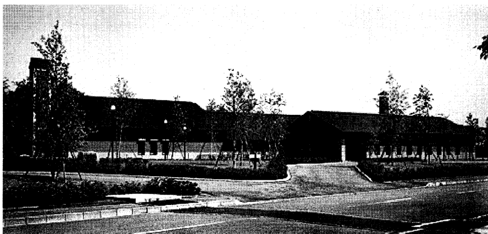
写真1. 仁科サイクロトロンセンター外観
