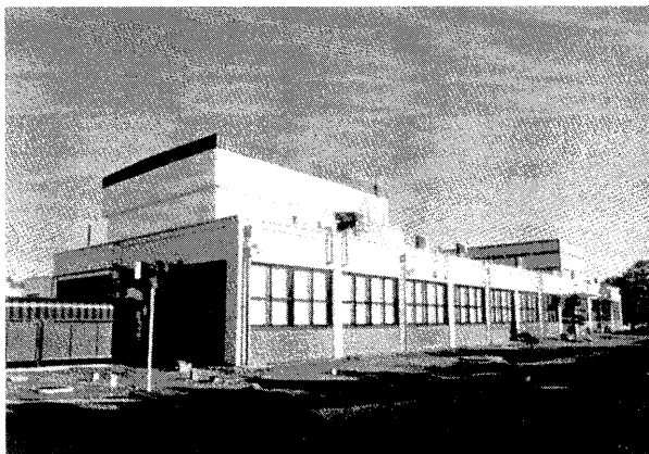
JRR-4 原子炉建家外観
